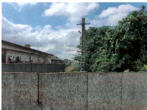
Vedere generala proprietate
