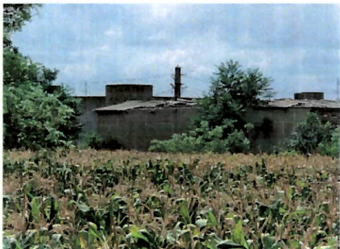
Vedere centrala termica C2
