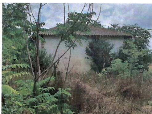
Vedere magazie C9
