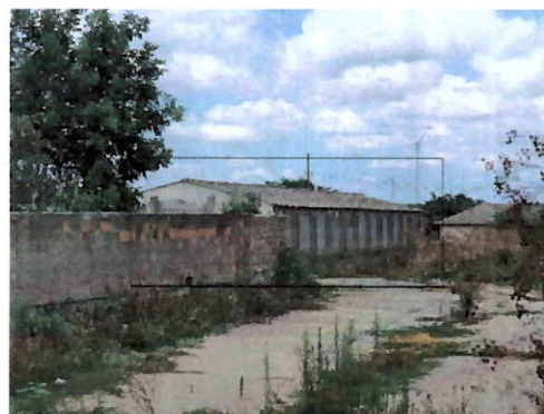
Vedere magazie C8
