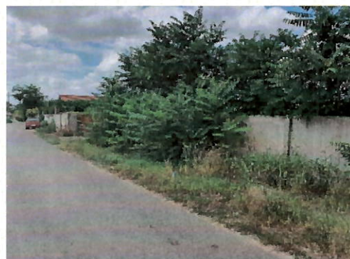
Vedere incinta din strada Crinului
