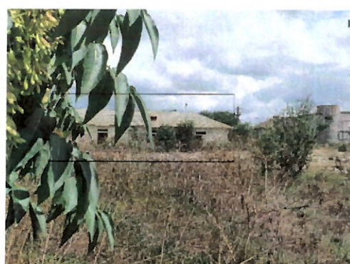
Vedere magazie C9
